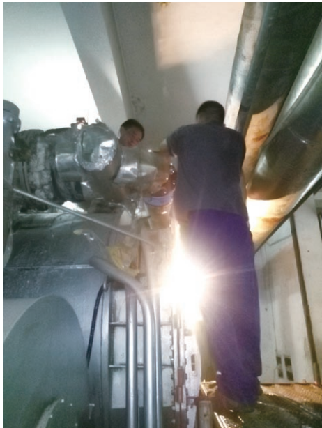
金狮大厦抢修现场
